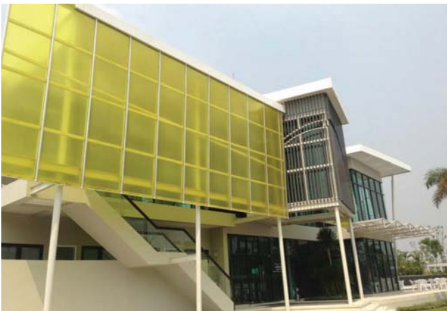
THE VILLA, บางบัวทอง Specification : PC Twin wall Sheet 6 mm.
